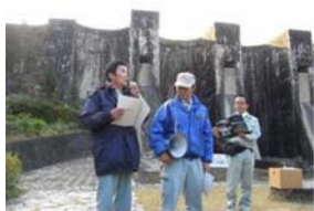
現地見学会の状況
