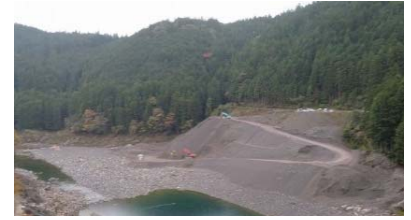
写真-3 長安口ダム置土状況
