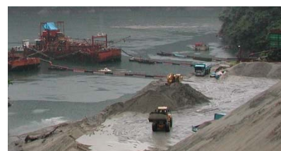
写真-1 佐久間ダムの堆砂除去
