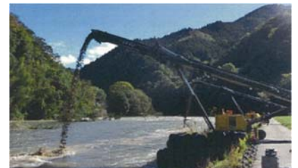
写真-4 矢作ダム給砂実験状況 3)
