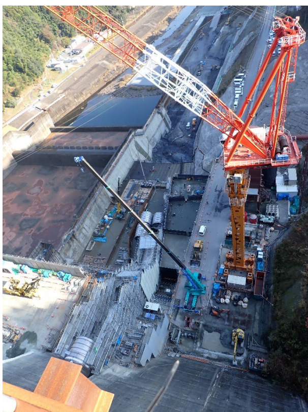
ダム天端より下流を望む (放流管設置および洪水吐き設置工事)
