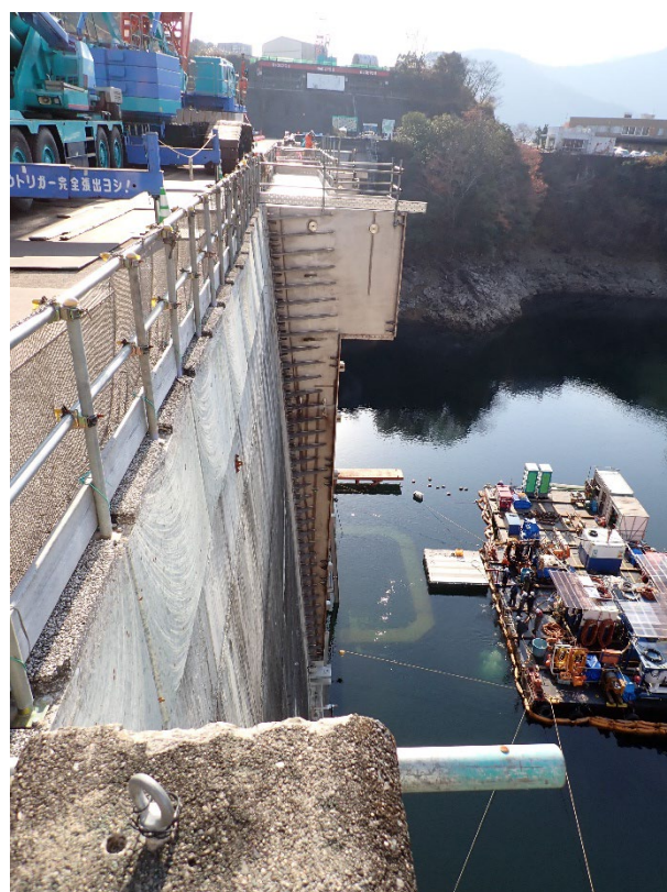
ダム天端より上流を望む (移設中の仮締切工の状況)
