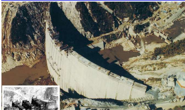
写真 2.14 矢作ダム(本体打設状況)
