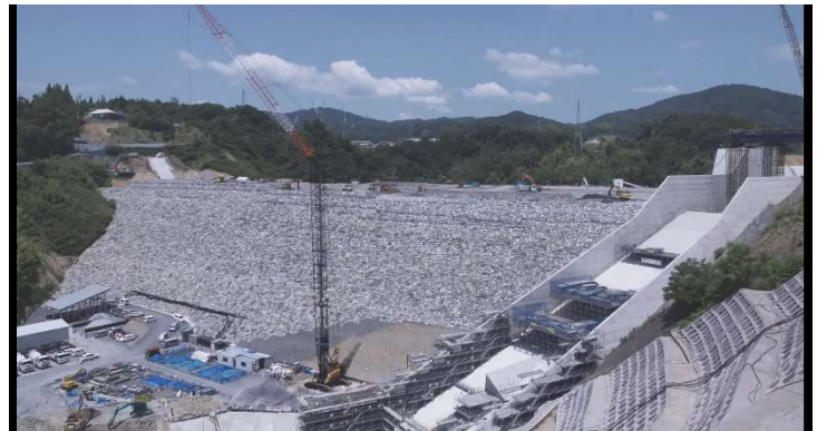
写真 2.5 安威川ダム現場映像(堤体下流面)
