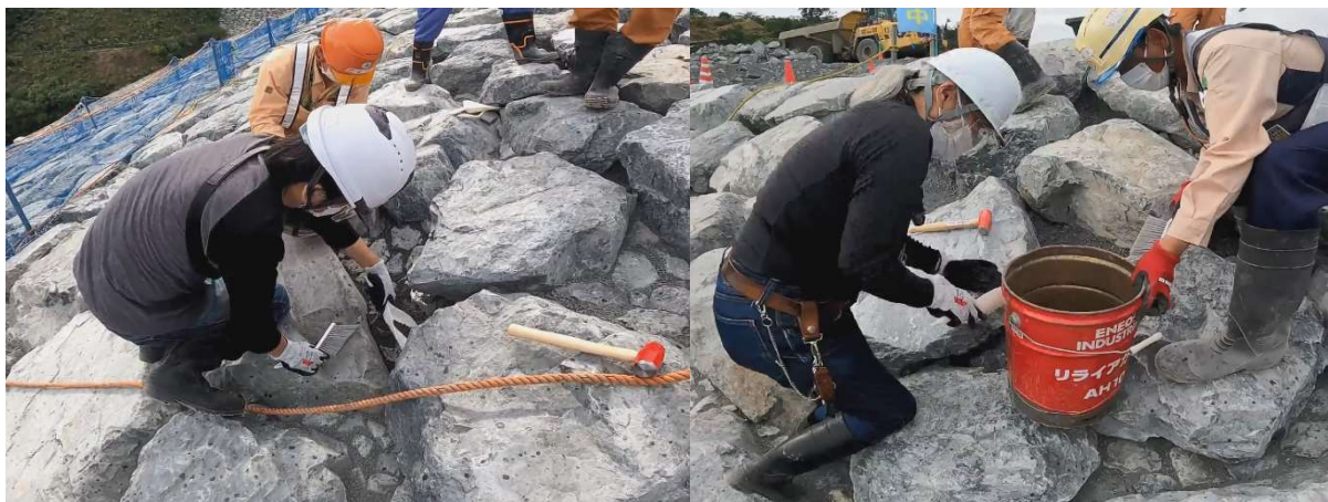
写真 2.6 安威川ダム現場映像(リップラップ間詰め作業体験)
