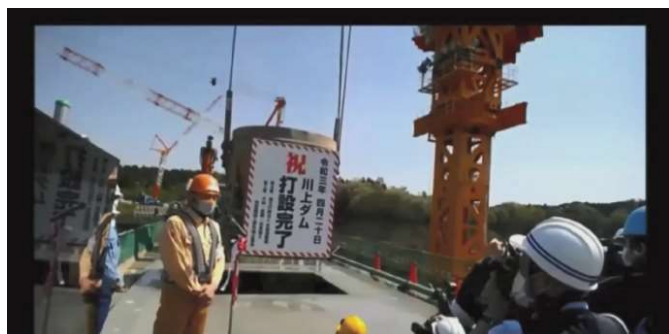
写真 2.8 川上ダム現場映像(打設完了式)
