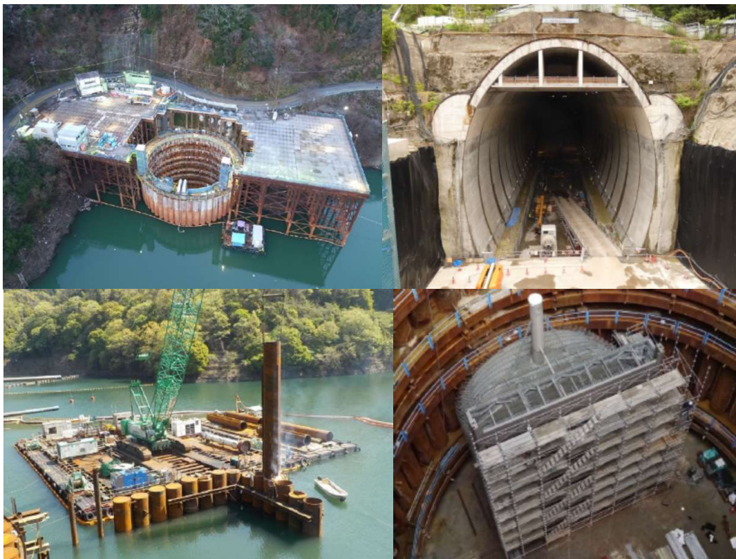
写真 2.20 天ヶ瀬ダム再開発(工事状況)
