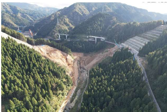
写真 2.12 足羽川ダム(工事状況)
