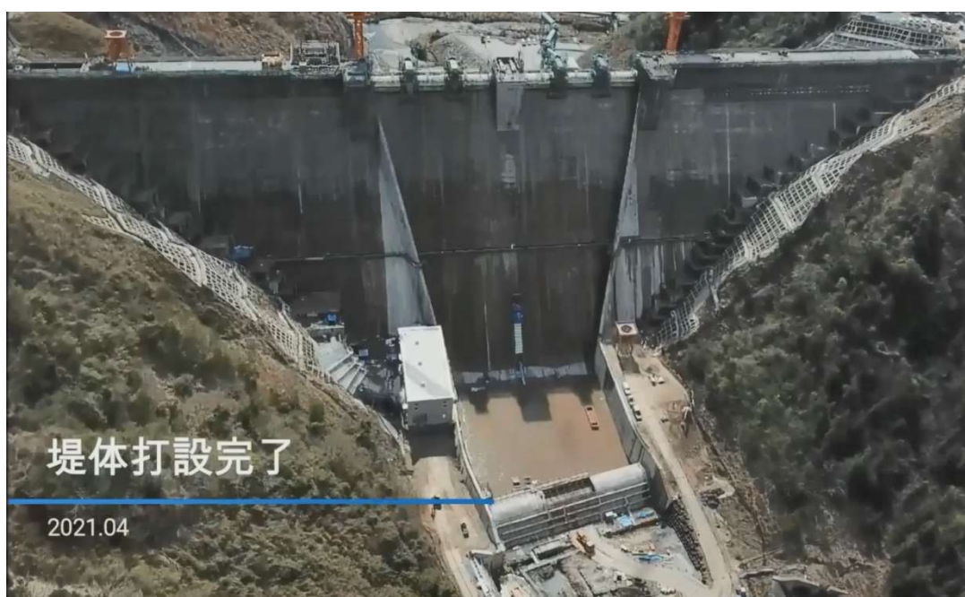
写真 2.7 川上ダム現場映像
