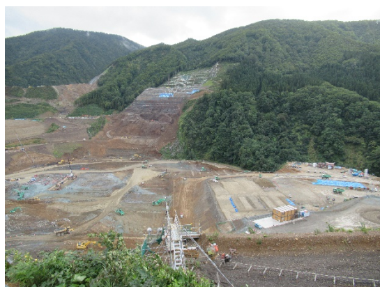
基礎掘削が進むダムサイト
