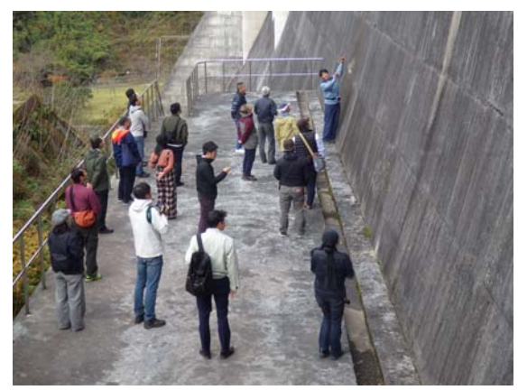
左岸フーチング
