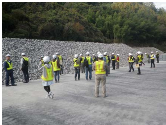
骨材仮置きヤード
