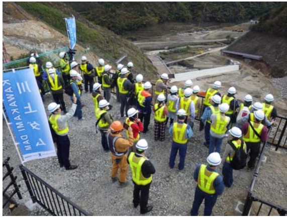
右岸ダム天端
