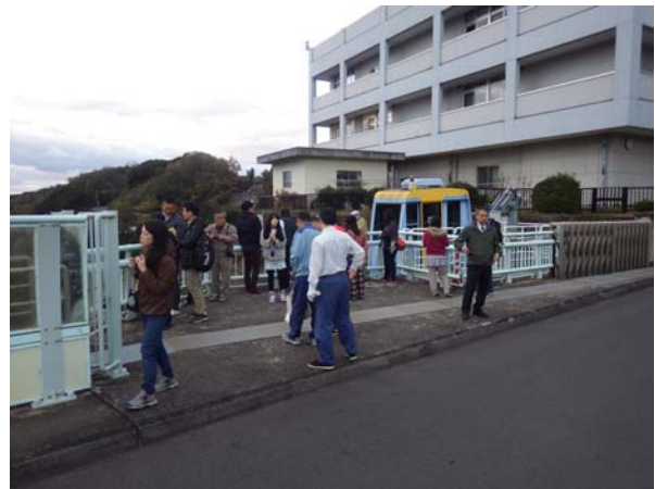
右岸アバット部
