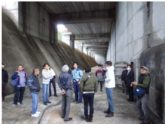
非常用洪水吐き天端側水路
