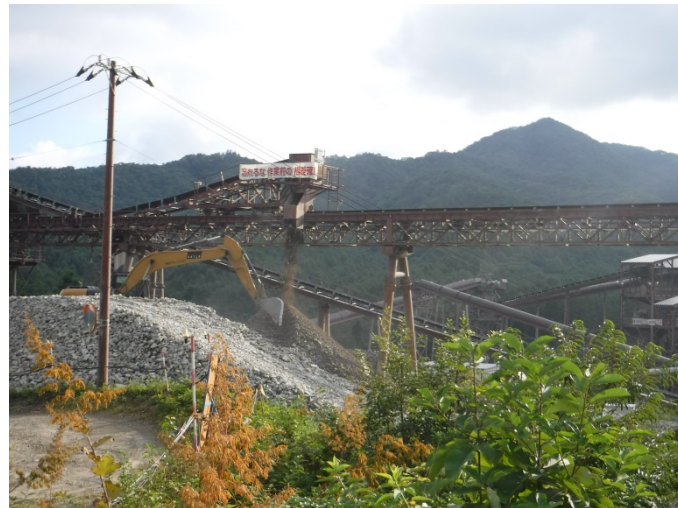
骨材プラントヤードの見学
