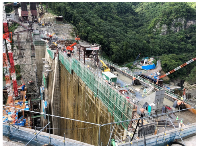
(上流右岸側から) ダム本体の施工状況の見学
