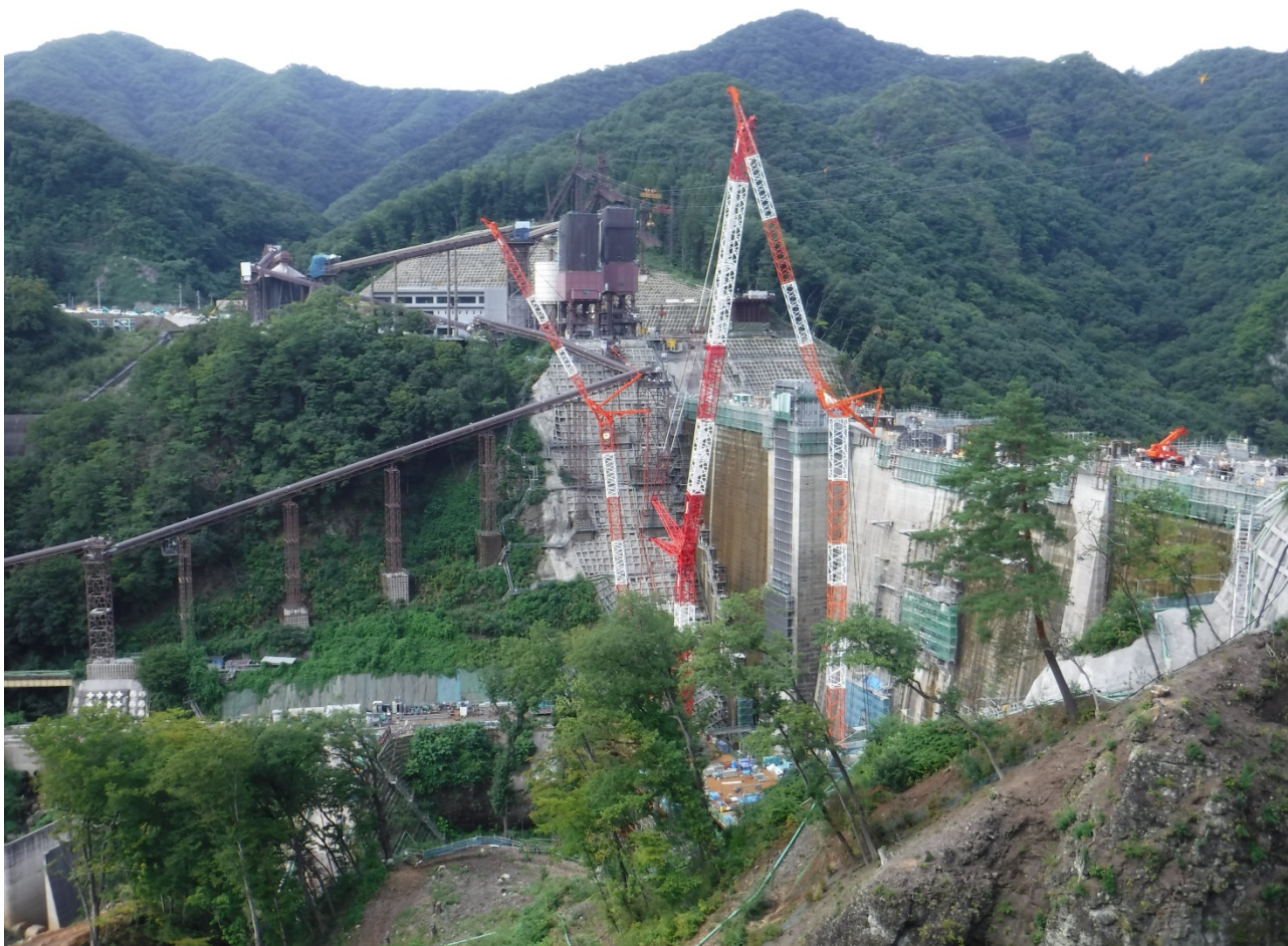
ハッ場ダム本体と長距離ベルトコンベヤ
