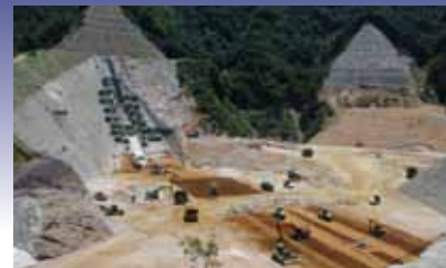
大分川ダム (大分県大分市) [建設中]
