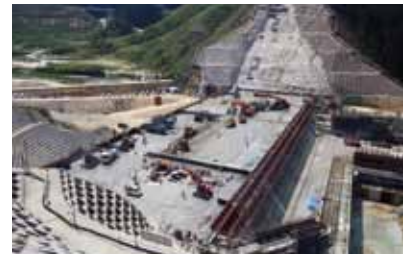
伊良原ダム (福岡県みやこ町) [建設中]
