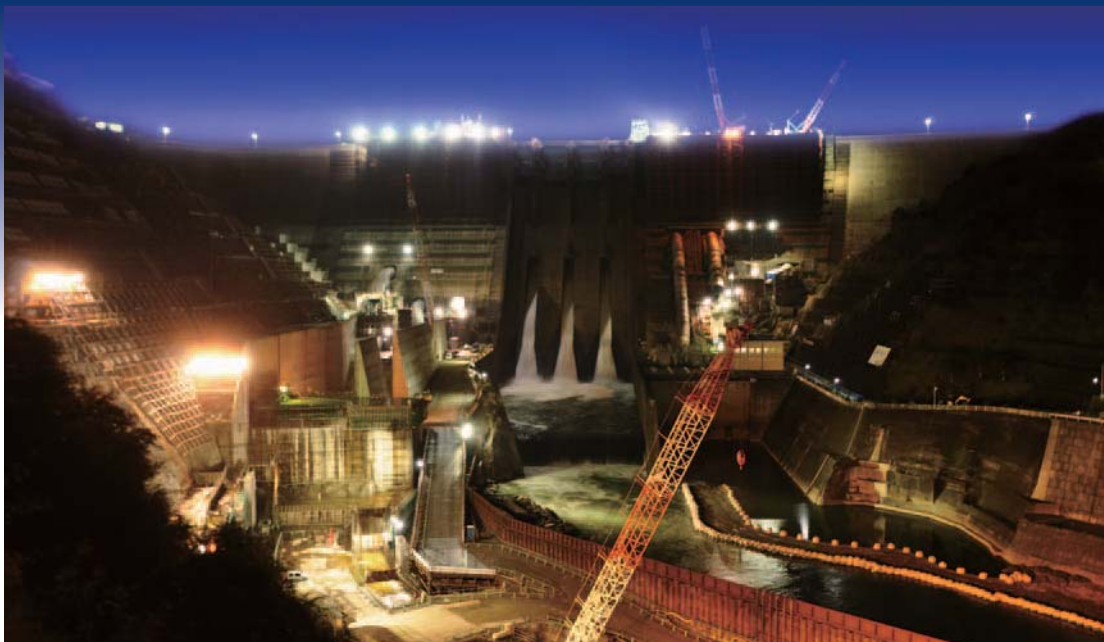
鶴田ダム (鹿児島県さつま町)
