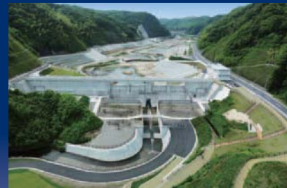
西之谷ダム (鹿児島県鹿児島市)
