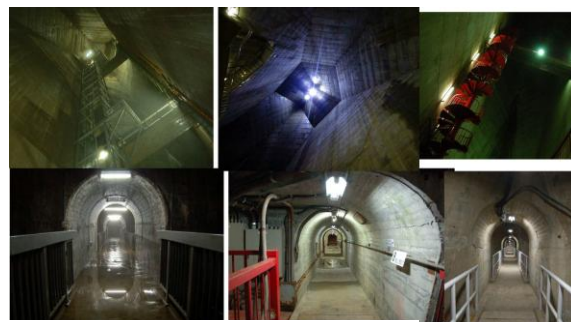
中空重力式ダムの内部 写真：夜雀
