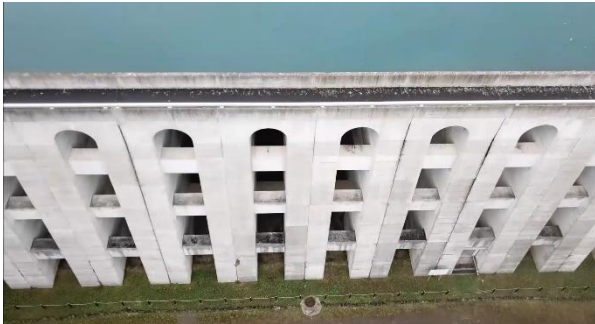
図 7 動画における笹流ダム・補強後のバットレス部
