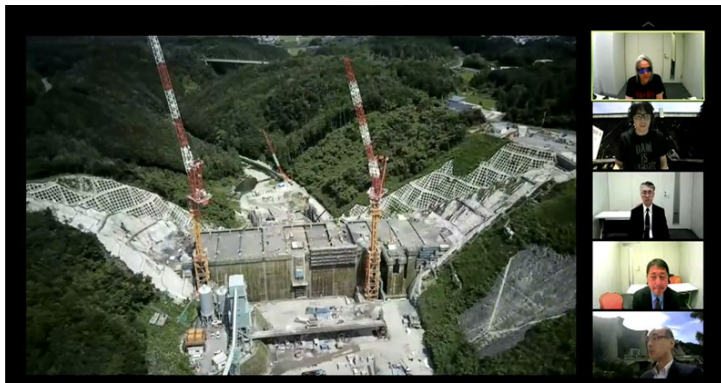
写真 2.4 川上ダム現場映像
