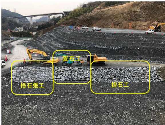
写真 2.9 安威川ダムリップラップ試験施工
