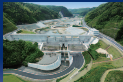
西之谷ダム（鹿児島県鹿児島市）
