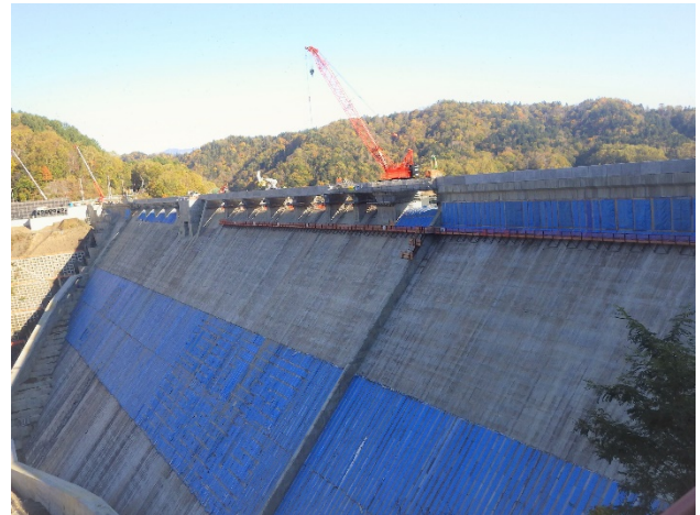
写真-2 見学時の状況(左岸下流より望む)
