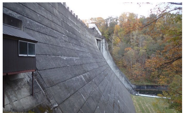
写真-2 雨竜第一ダムの堤体
