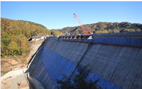
写真-3 新桂沢ダムの建設状況
