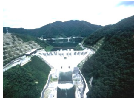
苦田ダム（国土交通省中国地方整備局）
