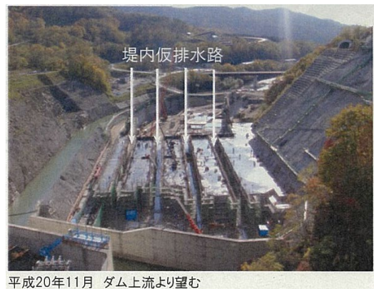
写真-2 堤内仮排水路（配布資料より）
