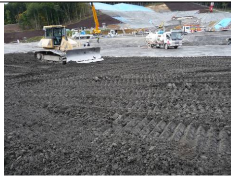
写真 3 CSG 打設、敷均しの様子
