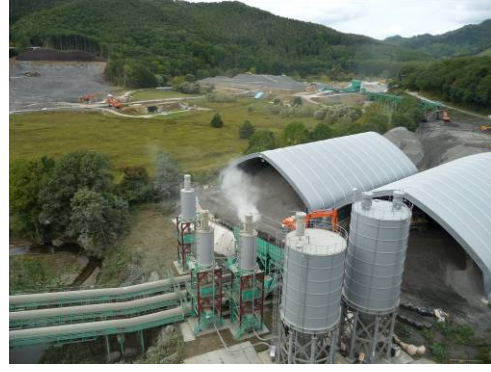
写真 2 CSG 保管場所、混合設備
